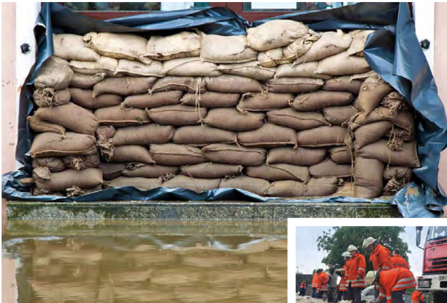
Schutzwälle aus Sandsäcken
