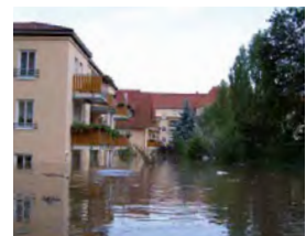
Hochwasser in der Stadt
